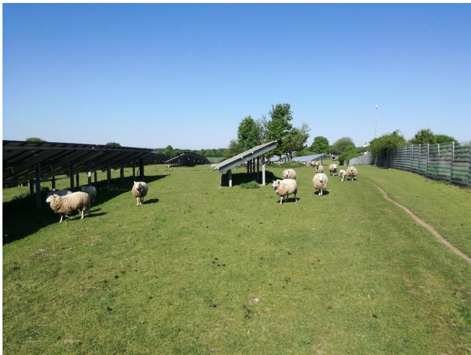
Solarpark Hürup (Quelle: Solar-Energie Andresen GmbH)
