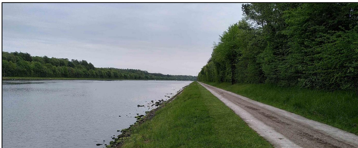
Abbildung 11: NOK mit Gehölz-bestandener Böschung auf der südlichen Seite
