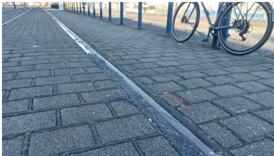
Bitumenverguss von nicht genutzten Gleisen
