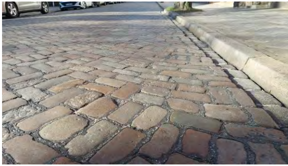
Fugenverguss bei Natursteinpflasterstraßen
