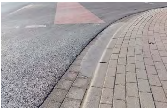
Bitumenkeil an Fahrradfurt
