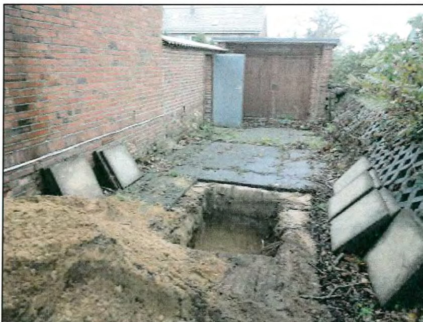
Abb. 2: Schurf S1 in der Einfahrt nordwestlich der Bebauung
