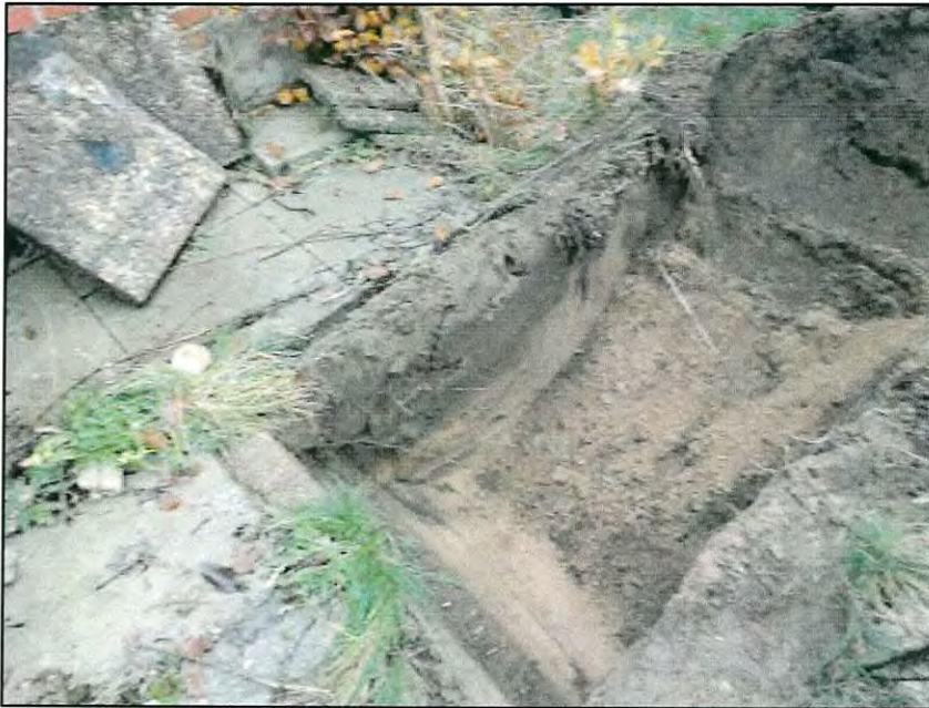
Abb. 3: Bodenschichtung im Schurf 2 mit Mutterboden über gewachsenen Sanden
